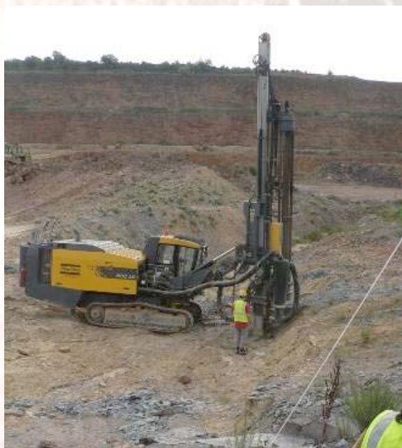
Figure 17 : Cutting au départ de la base de carrière.
